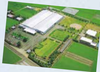
平成5年頃に空撮した工場写真。敷地面積は約12,000坪(建物は約2500坪)!
